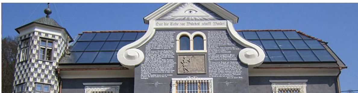
Abbildung 123: Ansicht des 70 m 2 umfassenden Kollektorfelds am Dach der Anlage „Hotel Metbräu“, Bildquelle: www.steirischesprung.at
