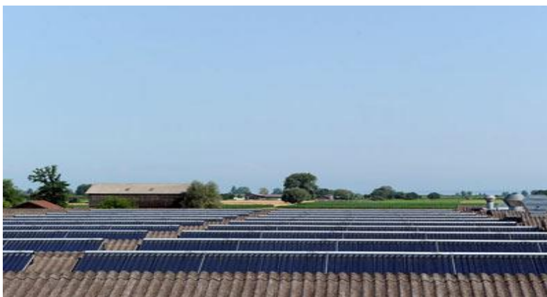
Abbildung 25: Ansicht des Betriebsgebäudes (rechts, Bildquelle: AEE INTEC) und Ansicht des 460 m 2 umfassenden Kollektorfeldes am Dach des Betriebsgebäudes der Anlage „Beschlägefabrik Julius Blum“ (links, Bildquelle: Ritter XL Solar)
