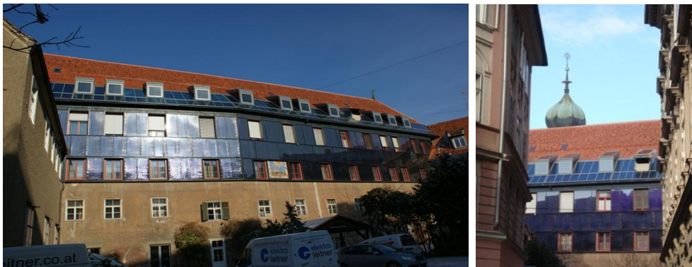
Abbildung 269: Ansicht des 210 m 2 umfassenden Kollektorfelds am Dach und der Fassade des "Franziskanerklosters Graz", Bildquelle: AEE INTEC
