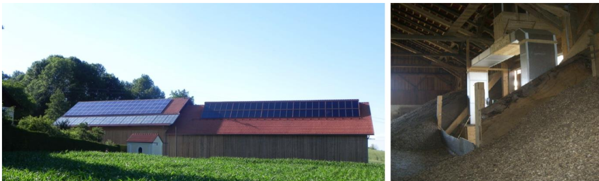
Abbildung 198: Ansicht des neu errichteten 102 m 2 umfassenden Kollektorfelds der Anlage „Holztrocknung Reich“ (linkes Bild, rechte Dachhälfte) sowie des Hackgutlagers und der Trocknungsanlage (rechtes Bild), Bildquelle: Rupert Reich
