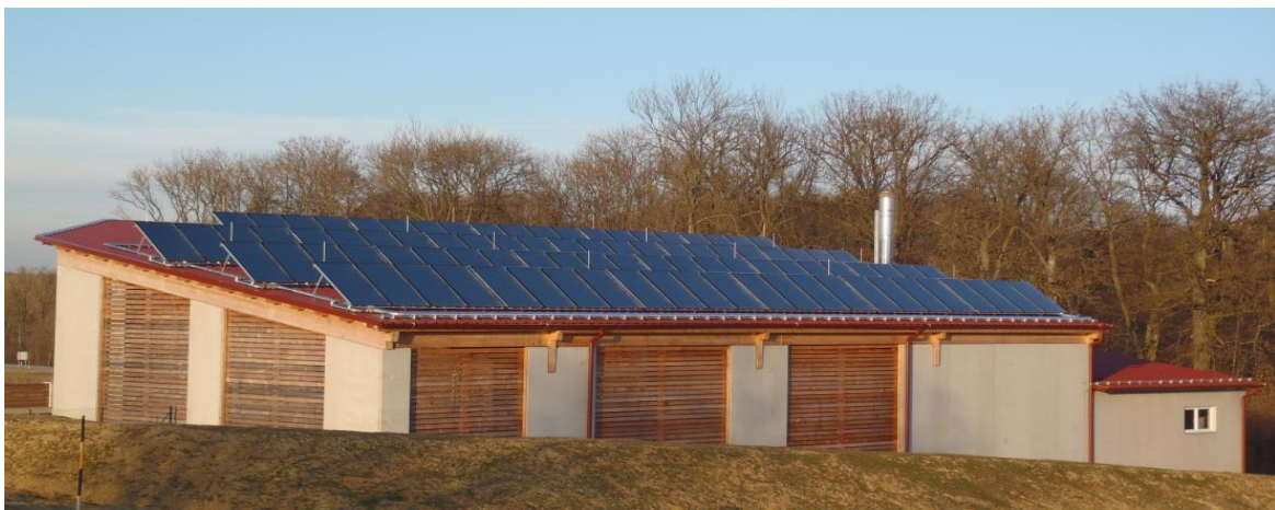
Abbildung 6: Ansicht des 250 m 2 umfassenden Kollektorfeldes am Dach des Hackgutlagerraumes der Anlage „Nahwärme Weichstetten“, Bildquelle: OÖ Gas-Wärme GmbH
