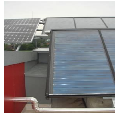
Abbildung 14: Ansicht der Anlage „Seniorenwohnheim Großklein“ und der formschön in das Gebäude integrierten Kollektorfläche (links) sowie des zweiten am Flachdach aufgeständerten Kollektorfeldes (rechts), Bildquelle: AEE INTEC
