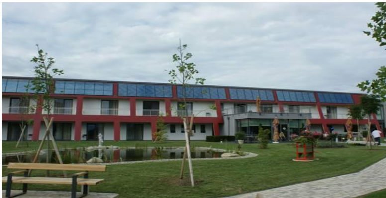
Abbildung 14: Ansicht der Anlage „Seniorenwohnheim Großklein“ und der formschön in das Gebäude integrierten Kollektorfläche (links) sowie des zweiten am Flachdach aufgeständerten Kollektorfeldes (rechts), Bildquelle: AEE INTEC
