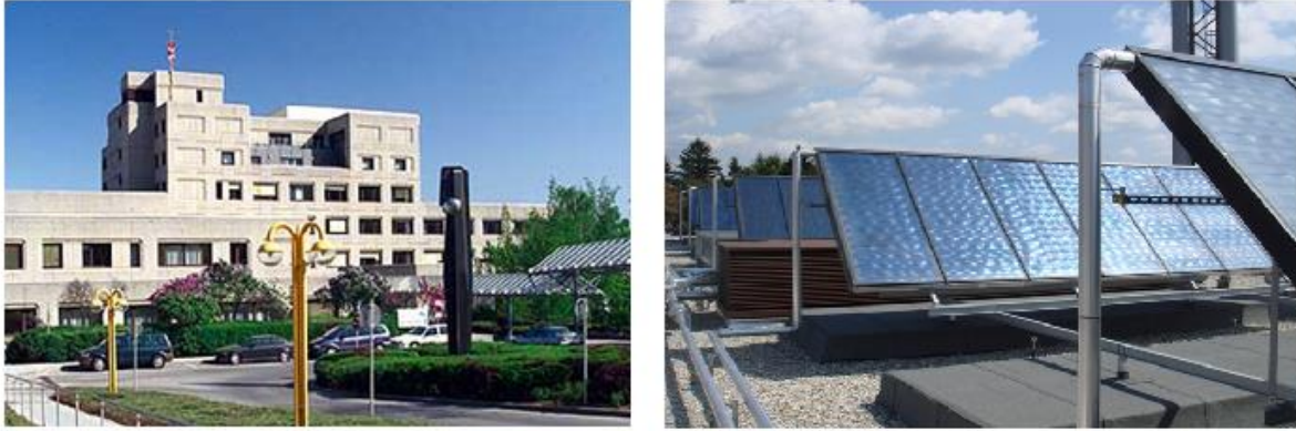
Abbildung 149: Ansicht des "Unfallkrankenhauses Graz" (links, Bildquelle: AUVA) und Ansicht des 210 m 2 umfassenden Kollektorfelds am Dach des Heizhauses (rechts, Bildquelle: AEE INTEC)
