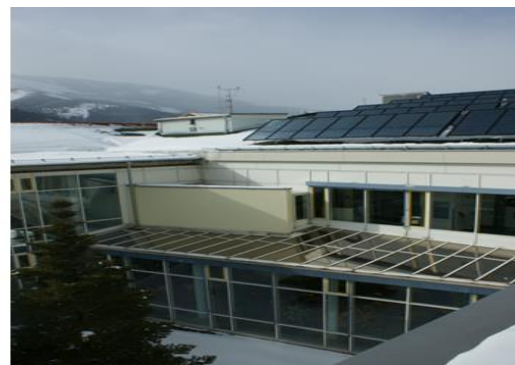
Abbildung 209: Luftaufnahme des „Unfallkrankenhauses Kalwang“ (links, Bildquelle: AUVA) und Ausschnitt der Gebäudeansicht mit der 208 m 2 umfassenden Kollektoranlage (rechts, Bildquelle: AEE INTEC)
