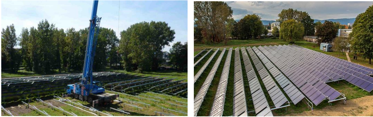
Abbildung 152: Ansicht im Zuge der Errichtung des Kollektorfeldes (linke Abbildung, Bildquelle: SOLID) und Ansicht des fertig errichteten Kollektorfeldes auf dem Gelände des Fernheizwerks Graz (rechte Abbildung, Bildquelle: „Kleine Zeitung“)
