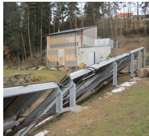
Abbildung 159: Restaurantgebäude (linkes Bild), aufgeständerte Kollektoren und Heizhaus (rechtes Bild). Quelle: AIT
