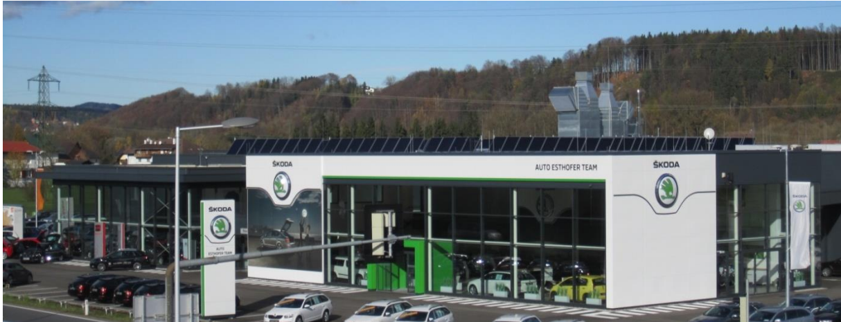
Abbildung 36: Südost-Ansicht des Gebäudes „Autohaus Esthofer“. Quelle: AIT
