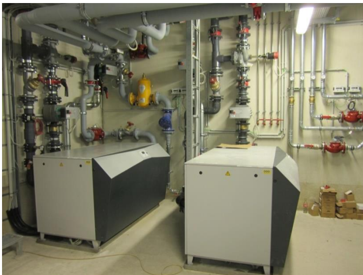
Abbildung 38: Ansicht der Heizzentrale bzw. der Wärmepumpen (linke Abbildung) und Darstellung der Verteiler und Verrohrung der Rohrregister für den Erdspeicher (rechte Abbildung). Quelle: AIT
