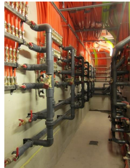
Abbildung 38: Ansicht der Heizzentrale bzw. der Wärmepumpen (linke Abbildung) und Darstellung der Verteiler und Verrohrung der Rohrregister für den Erdspeicher (rechte Abbildung). Quelle: AIT
