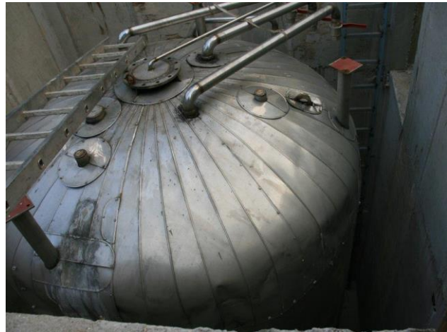
Abbildung 44: Darstellung des 30 m 3 Pufferspeicher während der Errichtung auf dem Betriebsgelände des landwirtschaftlichen Betriebs Schickmaier (Quelle: Schickmaier).
