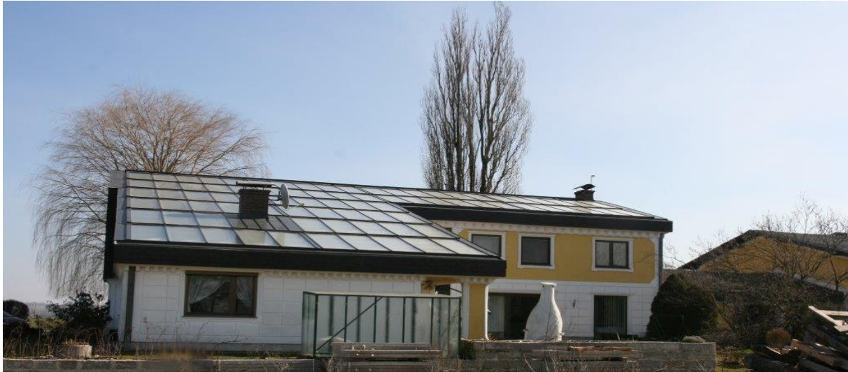
Abbildung 43: Ansicht des Wirtschaftsgebäudes bzw. des Kollektorfeldes der Anlage „Solare Trocknung Schickmaier“ (rechte Abbildung) sowie Ansicht des 30 m 3 Pufferspeichers während der Installation im Jänner 2015 (linke Abbildung) (Quelle: Schickmaier).
