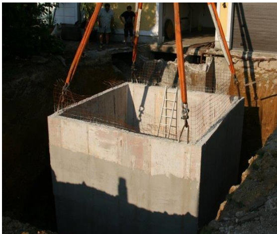
Abbildung 44: Darstellung des 30 m 3 Pufferspeicher während der Errichtung auf dem Betriebsgelände des landwirtschaftlichen Betriebs Schickmaier (Quelle: Schickmaier).
