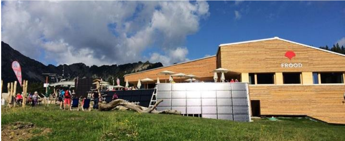
Abbildung 19: Ansicht des Bergrestaurants „Burtschasattel“ inkl. Ansicht des Hybridkollektorfeldes in der Fassade des Bergrestaurants im Vordergrund der Abbildung (Quelle: Frööd)
