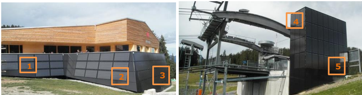
Abbildung 20: Darstellung der einzelnen Kollektorfelder der Anlage „Brandnertal Gastronomie“. Linkes Bild zeigt die beiden thermischen Flachkollektorfelder (1 und 2) sowie ein Hybridkollektorfeld (3). Rechte Abbildung zeigt zwei Hybridkollektorfelder an der Fassade der Bergstation (4 und 5). (Bildquelle: www.solartor.cc)
