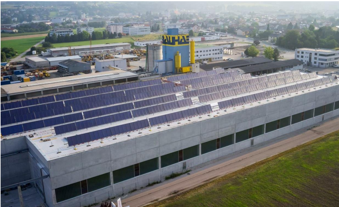
Abbildung 13: Ansicht der Fertigungshalle mit den aufgeständerten Kollektoren (Bildquelle: www.kuster.co.at )
