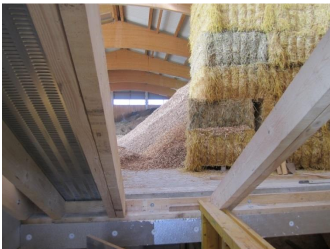
Abbildung 43: Ansicht von unten des zum Zeitpunkt der Aufnahme noch in Bau befindlichen Schrägrosts. Quelle: AIT
