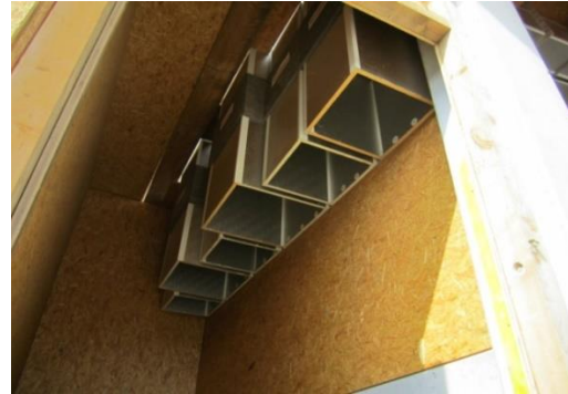
Abbildung 40: Auslassöffnungen der sechs Luftkanäle im Sammelschacht. Quelle: AIT
