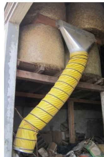
Abbildung 44: Luftverteiler für die Strohtrocknung. Quelle: AIT
