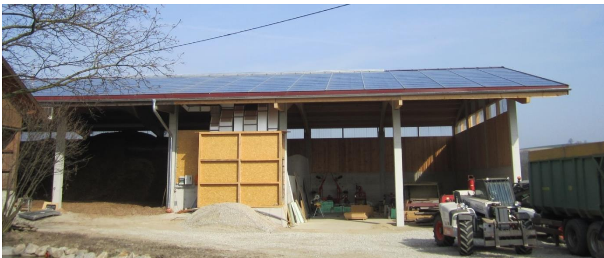
Abbildung 38: Süd-Ansicht der Halle mit der Luftkollektoranlage. Quelle: AIT
