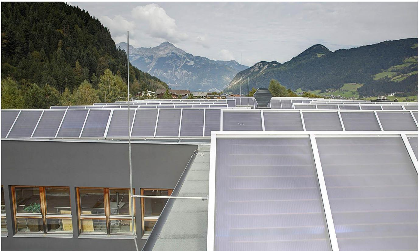
Bild: Thermische Solaranlage mit 300 m<sup>2</sup> Bruttfläche
