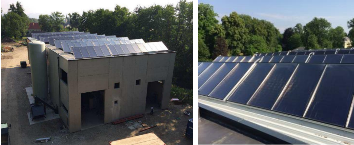
Abbildung 1: Ansicht des Regionalwärme Ebenthal mit den aufgeständerten Kollektoren am Dach des Heizhauses (Quelle: QM-Baubericht, BC Regionalwärme Ebenthal)
