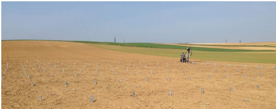
Abbildung 340: Montage der Stahlanker für die Aufnahme der Kollektoren am Betriebsareal (linke Abbildung, Bildquelle: ÖKOTECH) sowie beispielhafte Abbildung eines für die Montage des Kollektorfeldes verwendeten Stahlankers (rechte Darstellung, Bildquelle: terrafix)
