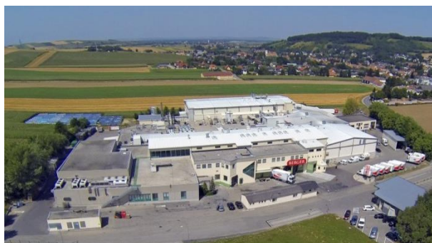
Abbildung 338: Ansicht der bodenmontierten 1.067 m 2 großen Kollektorfläche links (Bildquelle S.O.L.I.D.) und dem gesamten Werksareal rechts (siehe links hinten das Kollektorfeld, Bildquelle Fleischwaren Berger)
