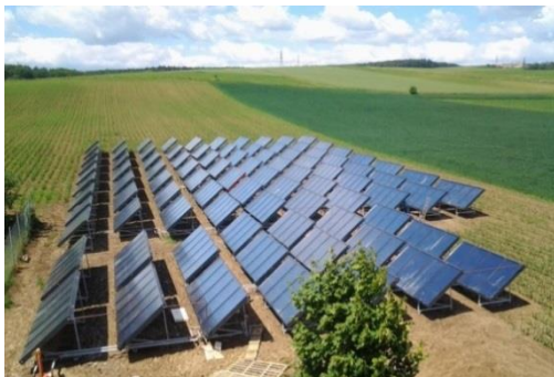
Abbildung 338: Ansicht der bodenmontierten 1.067 m 2 großen Kollektorfläche links (Bildquelle S.O.L.I.D.) und dem gesamten Werksareal rechts (siehe links hinten das Kollektorfeld, Bildquelle Fleischwaren Berger)
